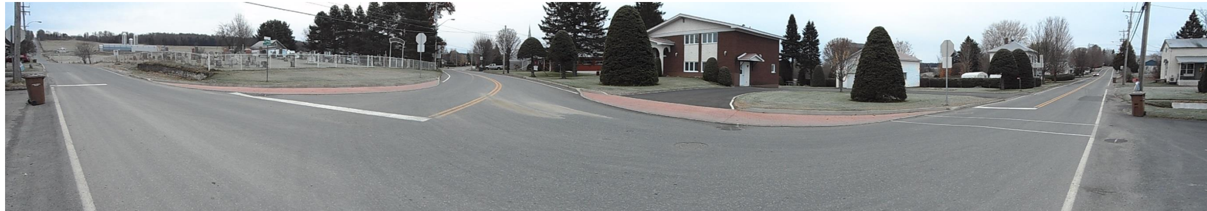
Figure 4.6.1a : Intersection de la route 251 et 206 à Martinville – Aménagement de l'intersection par un nouveau revêtement de sol – Vue panoramique
